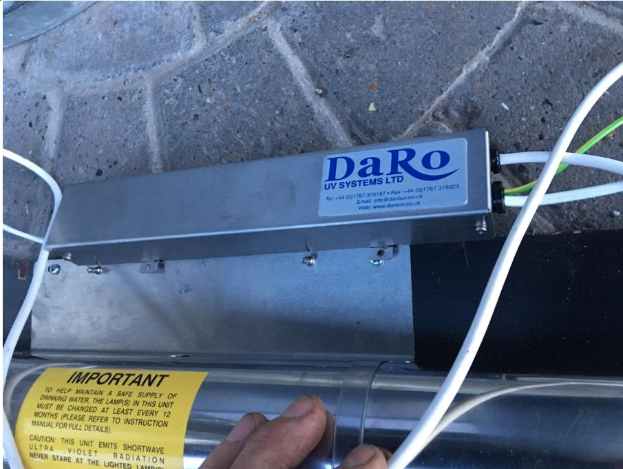
Strømforsyning løsnes fra klips på holderen, for at ledningerne til lyskilde bedre kan give sig.
