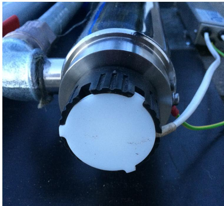
Monter de hvide plastikdæksel, så det klikker fast på det sorte plast.
