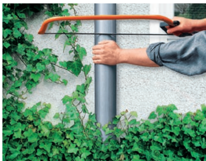
Udsavning af et ca. 30 cm langt stykke af nedløbsrøret
