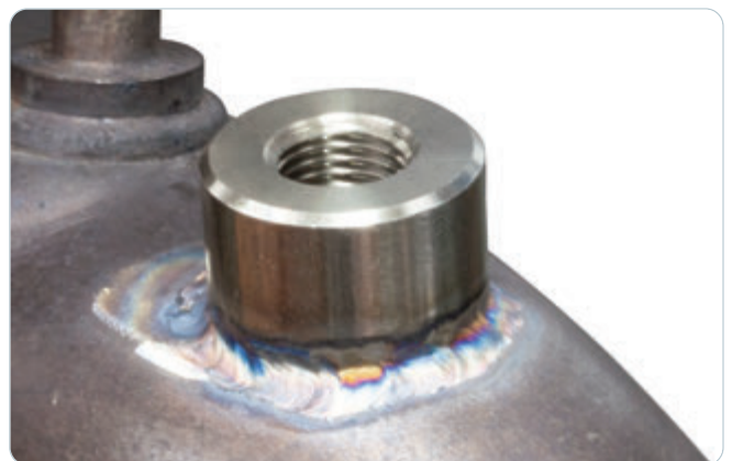
6. HJS Fitting einsetzen und verschweißen.
